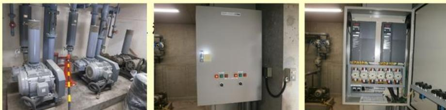
曝気ブロー3台中2台の更新を行い、2台をインバータ化することで7月5日では1台30%の削減で2台60%の削減が行えている。
